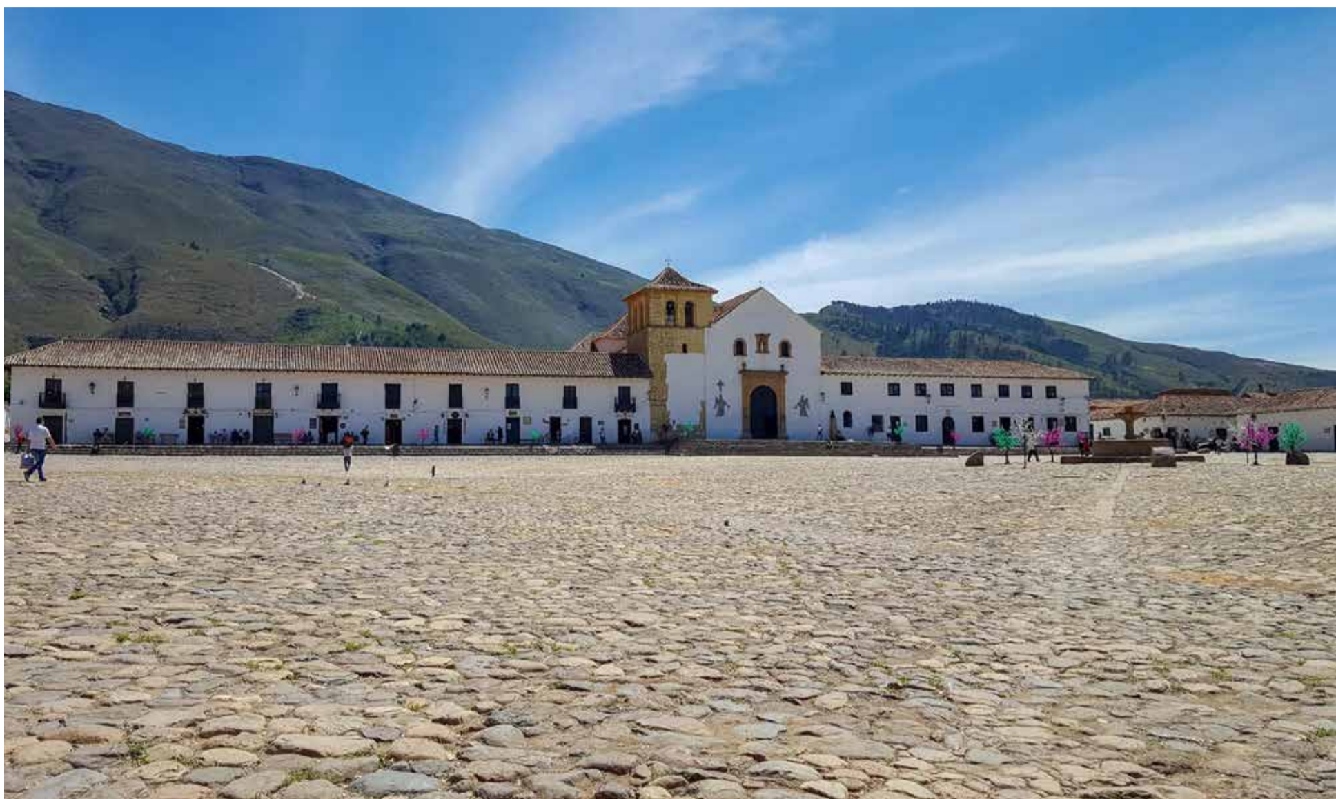
a plaza de Villa de Leyva con piso de piedras.
